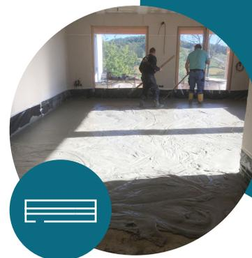
Lors de la mise en œuvre, une personne guide le tuyau de la pompe et une seconde personne répartit la mousse à l'aide d'une barre de polissage. À la fin, la surface est égalisée à l'aide d'une règle ou d'une planche.
