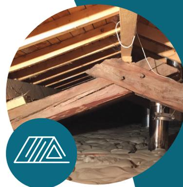
Airium™ est parfaitement adapté à l'isolation des combles, puisque sa structure minérale le rend ininflammable, empêche l'apparition de moisissures et le protège contre les rongeurs et la vermine. De plus, Airium™ est perméable à la vapeur d'eau, ce qui permet d'évacuer l'humidité générée par l'occupation d'une habitation. Celle-ci reste donc saine et bien isolée.
